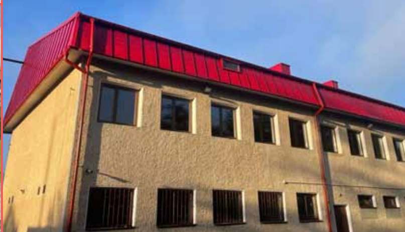
Wymiana pokrycia dachowego na budynku OSP Czerniec
